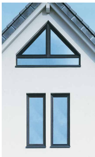
Pravouhlé, vysoko umístěné okno bez dělicích příček zdůrazňuje vertikály a optimalizuje přístup světla.
