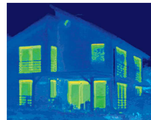
Po svědomité instalaci nových oken Schüco Corona CT 70 Classic dokazuje termografie vysoký energetický výnos investice. Původní energetická ztráta byla téměř bezzbytku eliminována.
